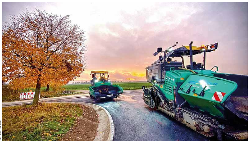
Foto: Fahrner Bau
